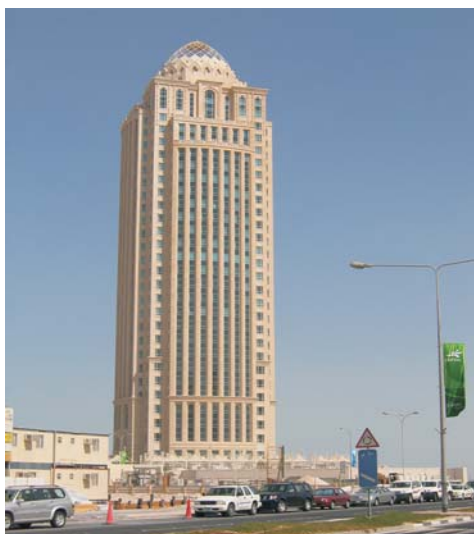
Qtel Buiding, Doha - Qatar
