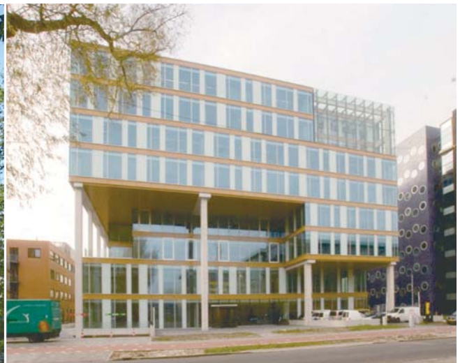
阿拉斯加大厦-冷辐射吊顶
