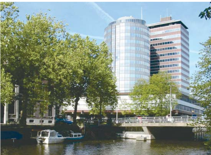
荷兰中央银行-冷辐射吊顶
